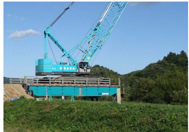
写真-2：一般国道 106 号宮古西道路 長沢川橋梁下部工工事
