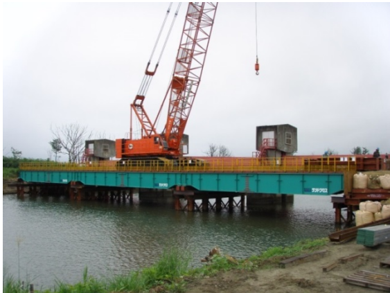
写真-1：貞山堀防潮水門旧施設撤去工事
