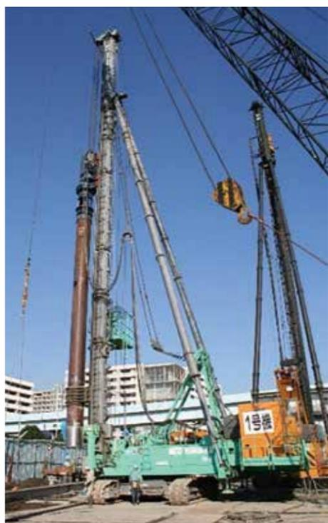
三点式杭打機とは、クローラークレーンをベースとした、1本のリーダーと2本のステーによる、三点支持式の杭打機です。リーダーに各種工法に対応した減速機・フロントアタッチメントを取り付け、これをトップシーブからワイヤーにて懸垂しています。主にオーガーの回転と自重にて削孔を行い山留杭、支持杭を打設します。三点式杭打機は主に大深度地下工事において広く採用されています。
