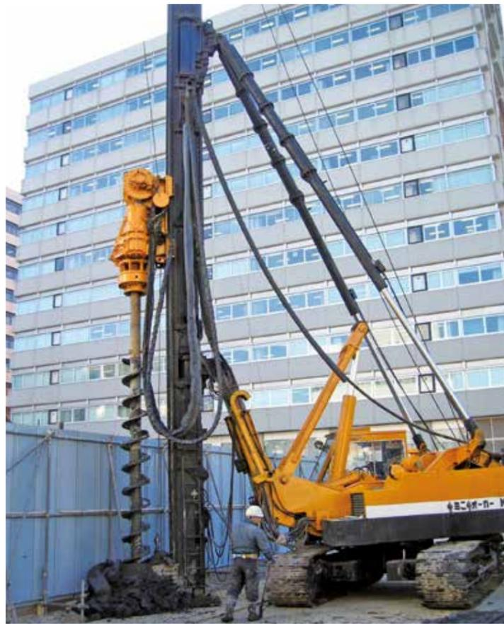
ミニ三点杭打機(ミニオーガー/パイルマン杭打機)とは、中型の三点式杭打機の名称で、リーダーに取り付けてある専用油圧オーガーをチェーン駆動によって動かすことで各種杭の圧入や地盤を削孔することができます。また、リーダーに折りたたみ機能を備えている為、重機回送・組立作業が容易です。
