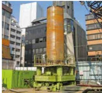
全回転掘削機とは、全回転オールケーシング工法に用いられる、高い鉛直精度と強力な押し込み力、最大級の回転トルクをもった回転式ケーシング圧入機です。
