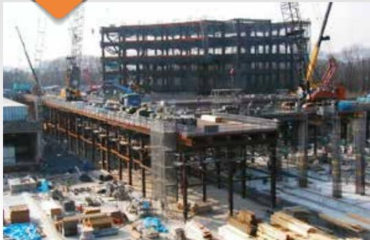
建築機械の作業スペースや工事用車両の通行、資材の仮置きスペースなどを確保する為の仮設橋梁の総称で建築・土木の分野を問わず広く施工されております。
