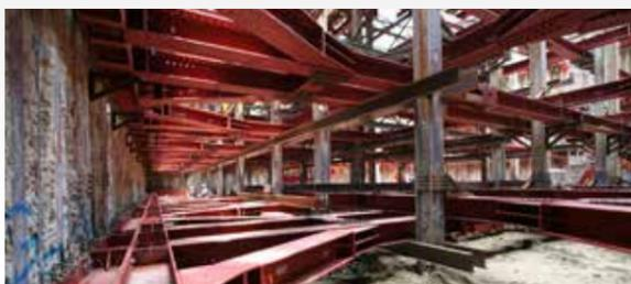
水平切梁は山留壁オープンカット工法で広く採用されている工法で、山留壁に作用する側圧を、切梁・腹起・火打などの鋼製山留支保工で支持します。腹起は山留壁面に沿って水平に取付け、切梁・火打と接合し、切梁は平面的に格子状に設置します。これを掘削深度に応じた計算に基づいた間隔で水平に配置、床付けまでの掘削を可能となります。軸力を受ける切梁の座屈防止及び、切梁の自重を受ける為に中間杭を設置します。
