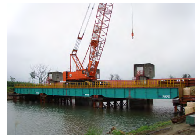
宮城県／貞山堀防潮水門旧施設撤去工事 幅員:8.0m、橋長:50.0m(3径間)
