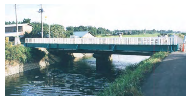
千葉県/市場橋 幅員:2.0m、橋長:23.0m
