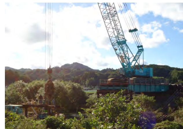
岩手県／一般国道106号宮古西道路長沢川橋梁下部工工事 幅員:8.0m、橋長:16.0m
